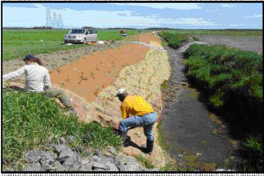
Figure 9. Ensemencement d'herbacées avec arbustes en talus au site de Saint-Tite (photo : S. Duranceau).
