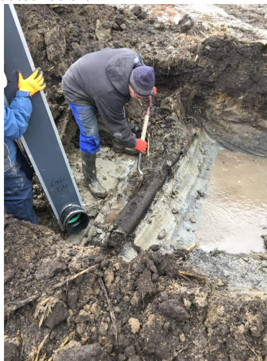
Étape 2 : Nettoyer autour du drain.
