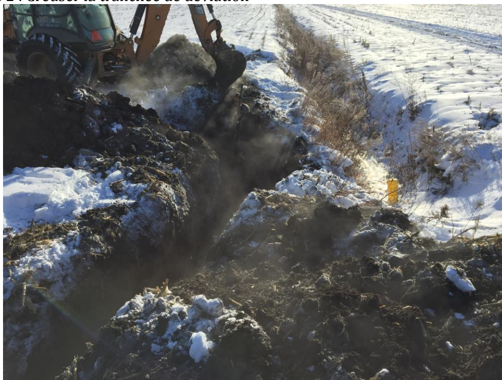
Étape 2 : Creuser la tranchée de déviation
