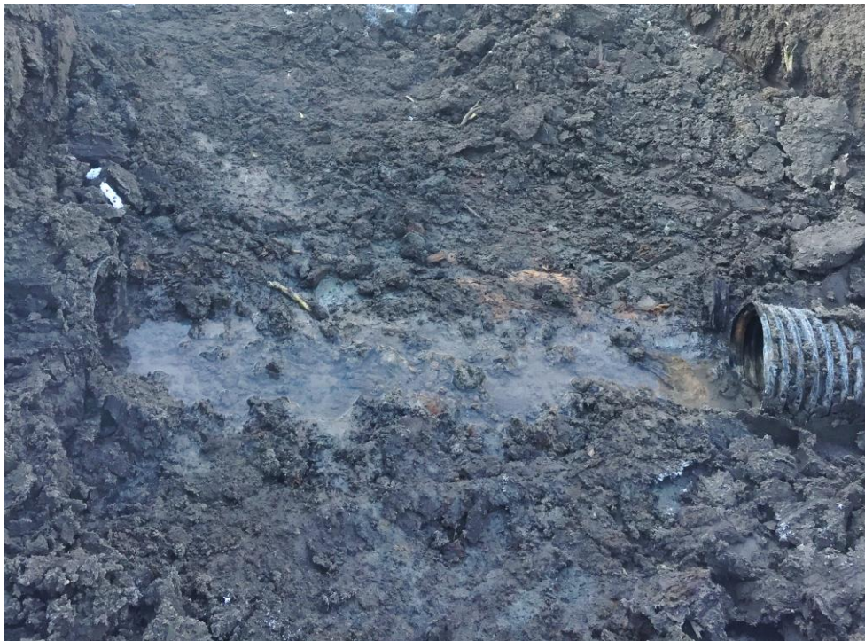
Étape 2 : Creuser la tranchée de déviation
